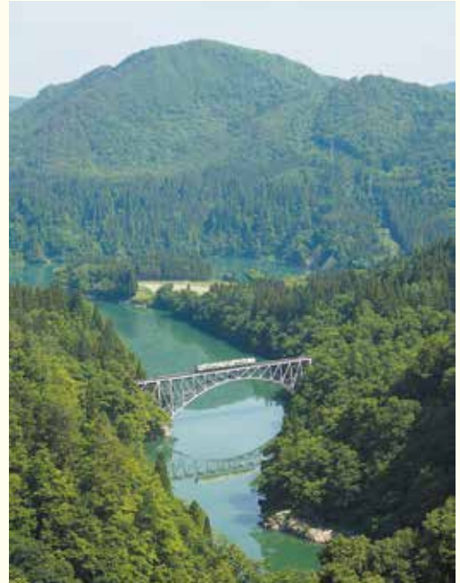
◀第一只見川橋梁ビューポイント
