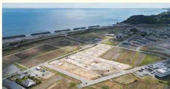
▲ 広野駅東側の住宅整備区域
